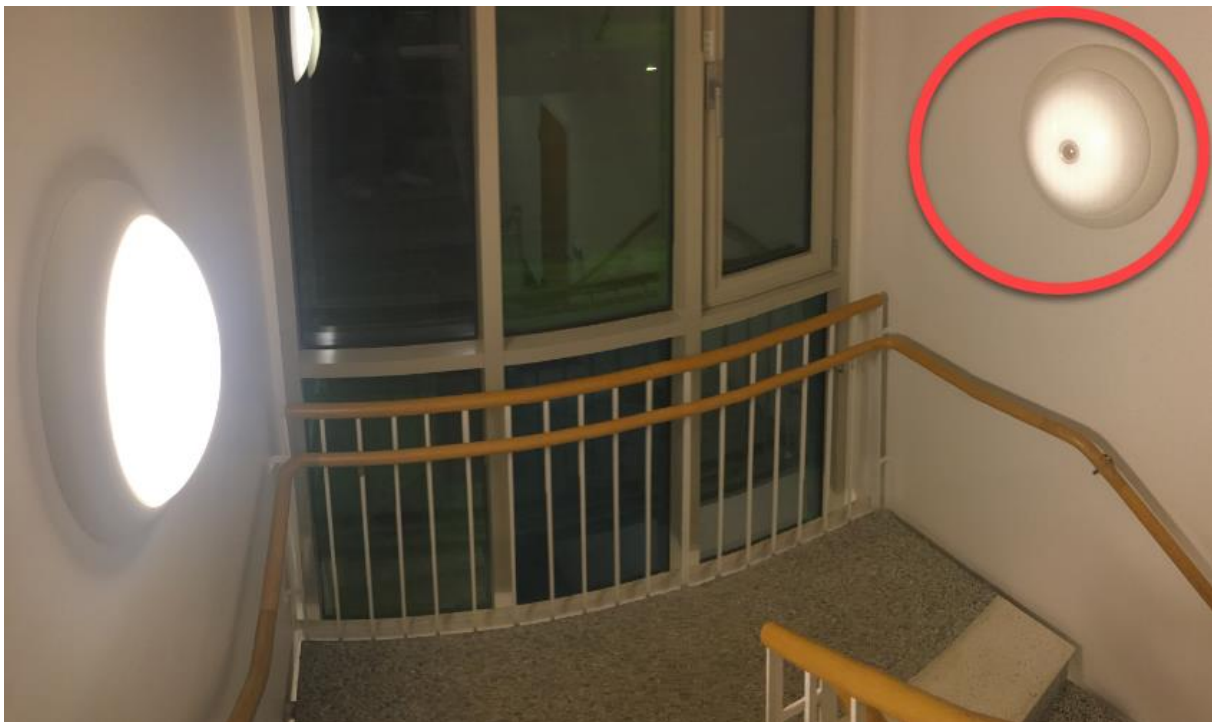
Armatyr har en trasig rörelsedekare, trapphus 26E
